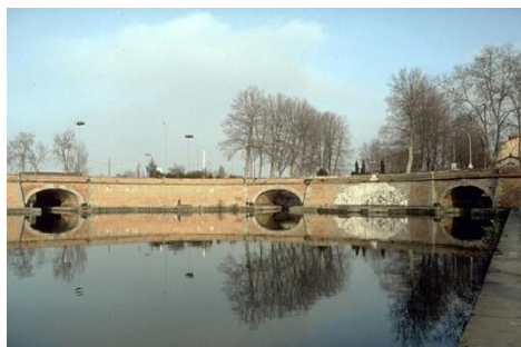
Port de l'Embouchure, vue d'ensemble des trois ponts. Photo Noé-Dufour Annie, (c) Inventaire général Région Occitanie, 1996, IVR73_19963100966ZA.
