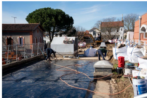
Toulouse. Février 2024. Vue de la partie sud-est du chantier d'imperméabilisation des toitures végétalisées du bâtiment des Archives municipales. Clara Javierre, Stéphanie Renard - Mairie de Toulouse, Archives municipales, 4Num_nc.
