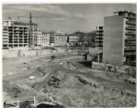
Quartier Saint-Georges. Creusement du parking. 27 février 1974. Mairie de Toulouse, Archives municipales, 3Fi302.
