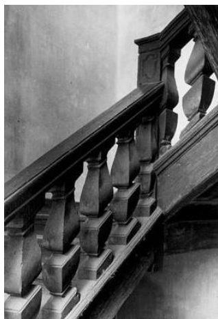
Rampe à balustres en bois de l'escalier de la maison d'Adéguier, dite hôtel Marvejol. Phot. Hurault, Charles. Fonds photographique du Centre de recherches sur les Monuments historiques, APMH00141082.
