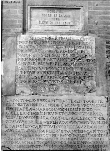
Plaques commémoratives encore en place au moment de la démolition des moulins du Château Narbonnais, cliché Direction des Travaux Publics, 5 mai 1942, Mairie de Toulouse, Archives municipales, 16F11_2.
