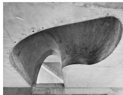
Escalier de l'immeuble sis au 9 boulevard des Minimes, par les architectes Paul Gardia et Maurice Zavagno, 1958. Jean Dieuzaide – Mairie de Toulouse, Archives municipales, 84Fi_nc_Avenirdubatiment026.
