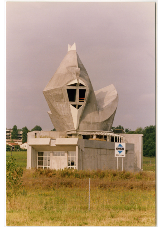
« Fondation Inard (1993). Etat des travaux après refus d'utilisation ». Pôle Image de la direction de la communication (ville de Toulouse), détail. Mairie de Toulouse, Archives municipales, AMT, 1Fi131.
