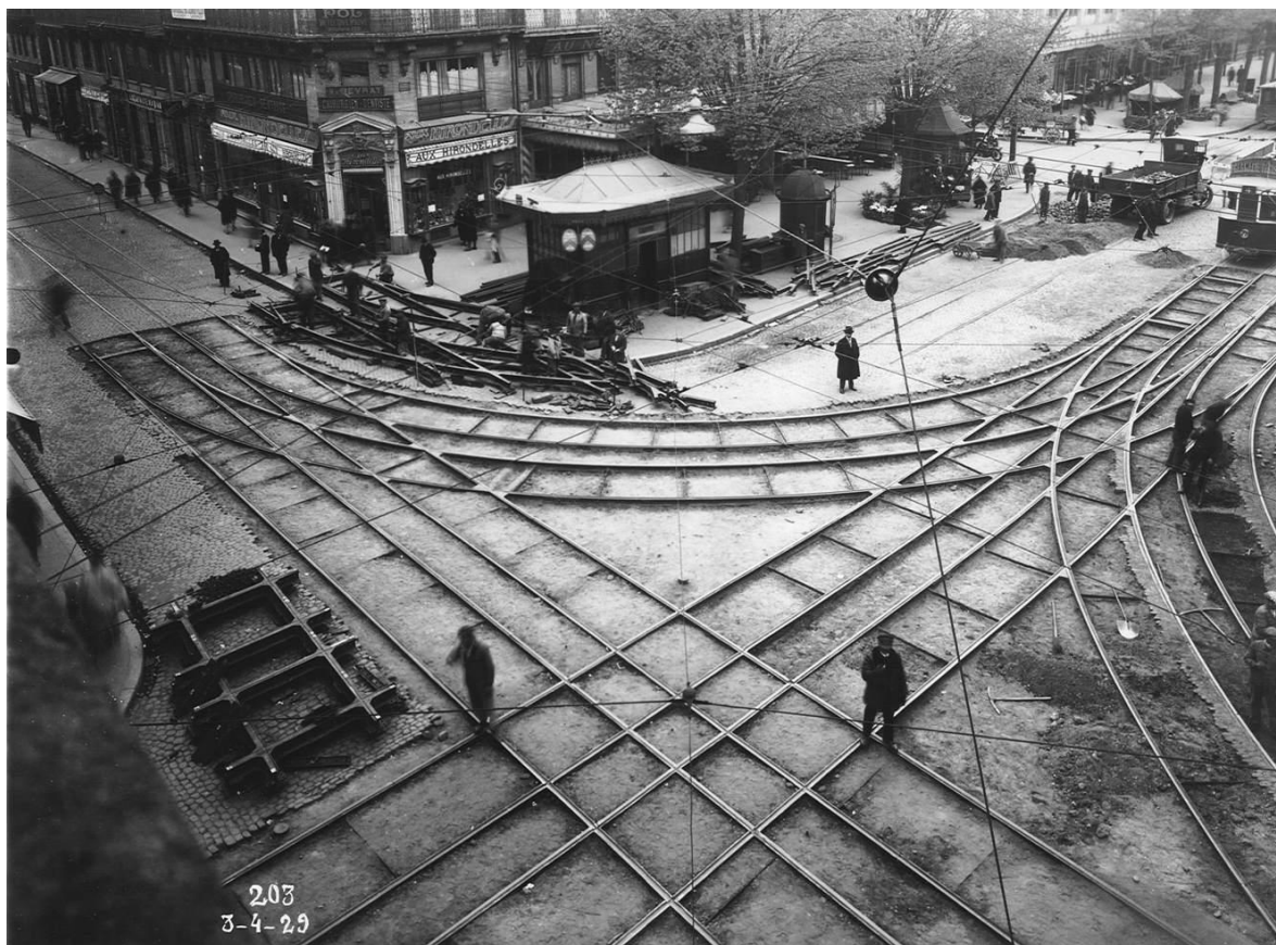
Pose de rails et électrification : des travaux d'envergure sur la voirie. A.M.T., 2 Fi 786.
