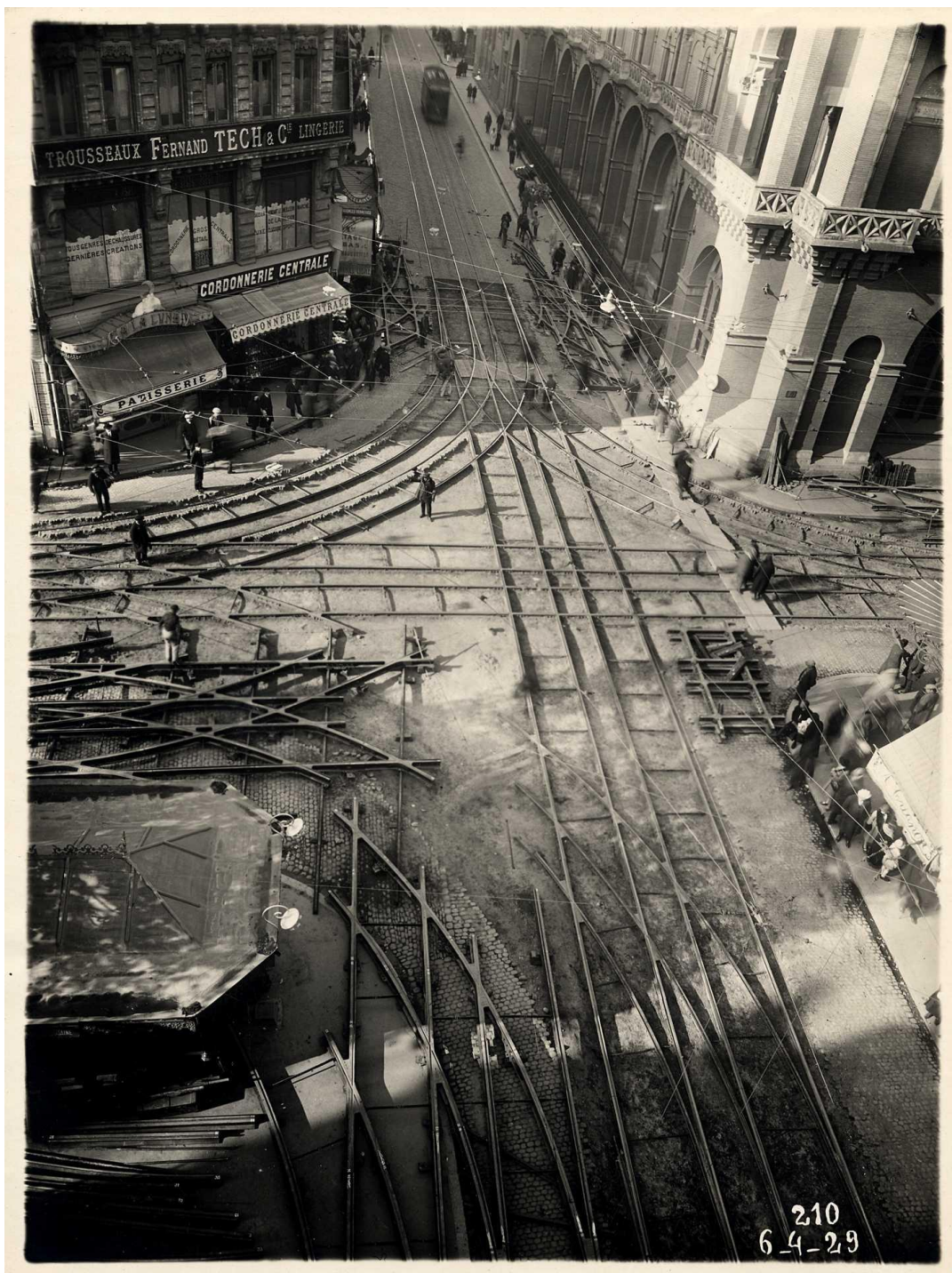
Pose de rails de tramway, carrefour de la rue d'Alsace et de la rue de Metz, 1929. Photographie noir et blanc. A.M.T., 2 Fi 793.
